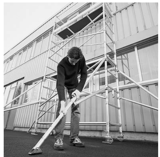
Fig. 3: la notice de montage indique à partir de quelle hauteur et comment les appuis doivent être installés.
