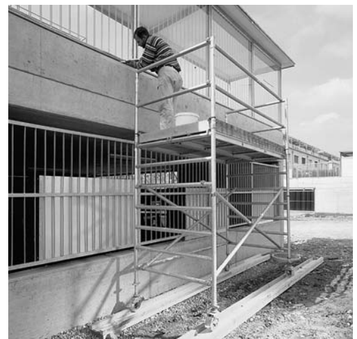
Fig. 2: un support résistant empêche l'échafaudage roulant de s'enfoncer brutalement.
