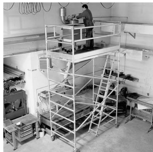
Fig. 6: l'absence de protection latérale et un platelage défectueux entraînent souvent la chute de personnes.
