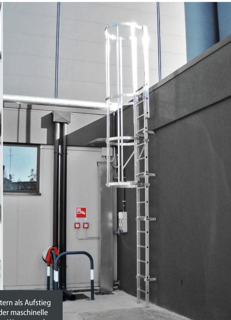
Sichere Steigleitern als Aufstieg auf Gebäude oder maschinelle Anlagen, z. B. zur Wartung oder Instandhaltung.
